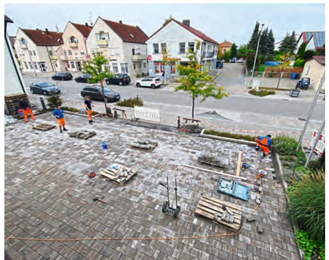
Pflasterarbeiten Parkplatz Rathaus Aiterhofen
